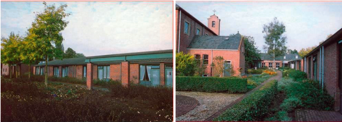
Een deel van het kloostergebouw aan de buitenkant
