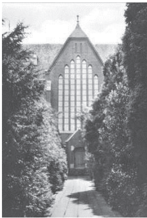
De zij-ingang van de kapel die men gebruikt om vanuit de afscheidsviering van een overleden medezuster naar het kerkhof te wandelen voor het definitieve afscheid
