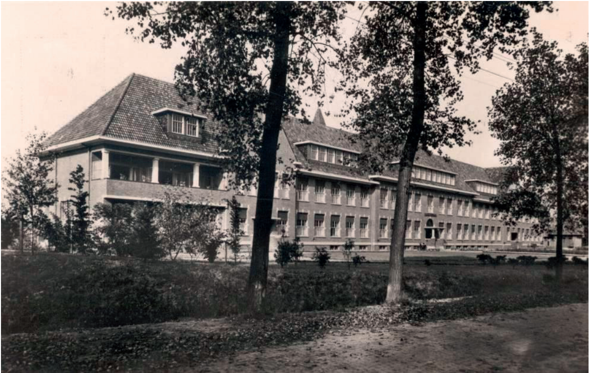
Gezicht op de voorgevel van west naar oost gezien vanuit de voortuin
