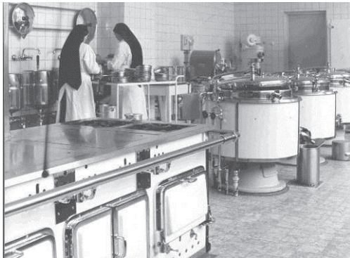
De centrale keuken in het moederhuis van 1960
