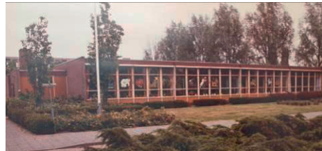
Het kleutergebouw van de Rietvinkjes aan de Rietbeemdweg
