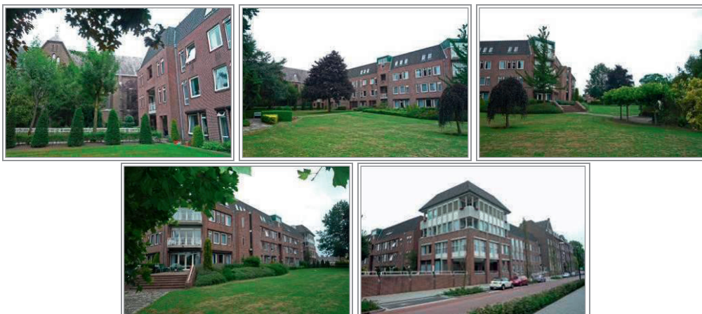
Wie om de gerealiseerde nieuwbouw heen loopt ziet vanuit verschillende hoeken het volgende exterieur met tevens delen van de schitterende kloostertuin als een oase van groen te midden van de bebouwing [fotocollectie Jan van den Bosch]
