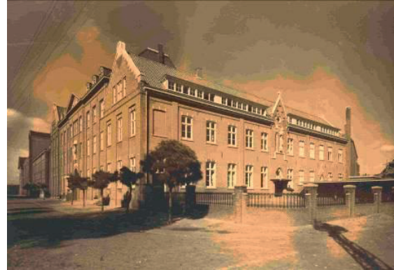
De vleugel van het gasthuis op de hoek van de huidige Kloosterstraat/Pastoor van Erpstraat die in 1934-1935 ingrijpend is verbouwd.
