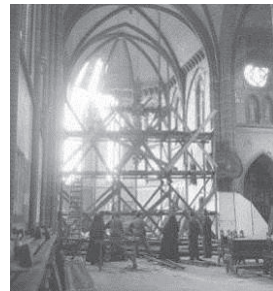
Enkele zusters en werklieden kijken toe hoe de restauratie verloopt
