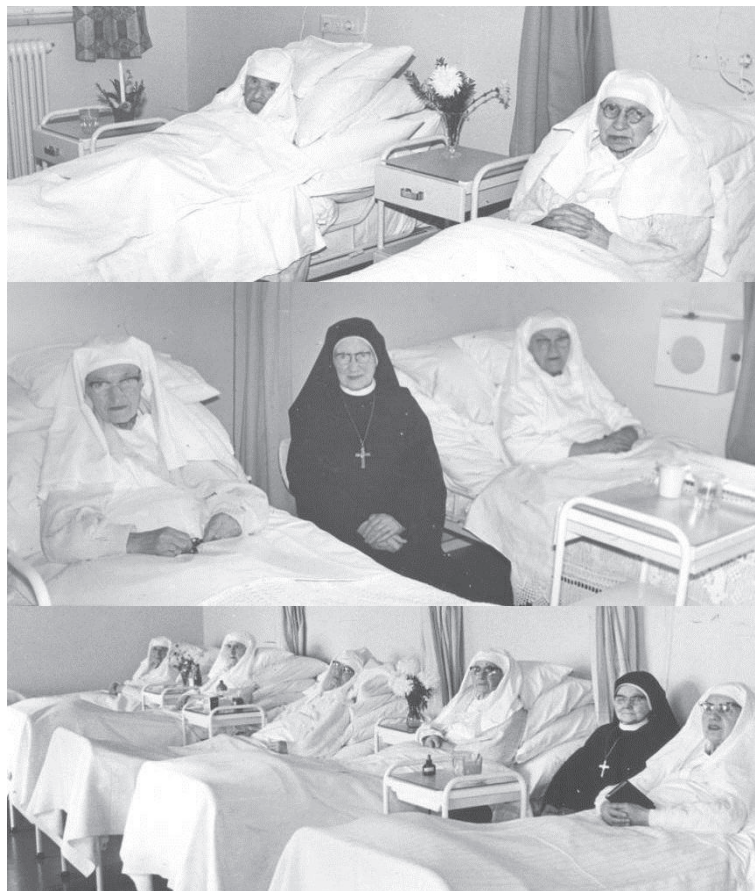
Interieurfoto's van de ziekenzaal voor de zusters
