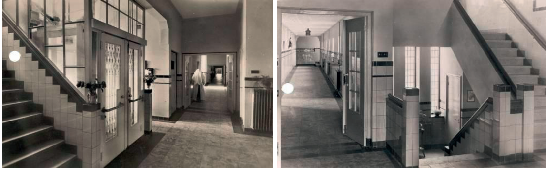
Interieurfoto van een van de gangen en de trappenhal
