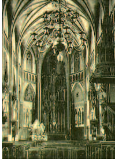
Oud interieur van de Servatiuskerk met zijn basiliekvorm zoals die is herbouwd in 1839 terwijl de middeleeuwse kerk voorzien was van kruisbeuken.
