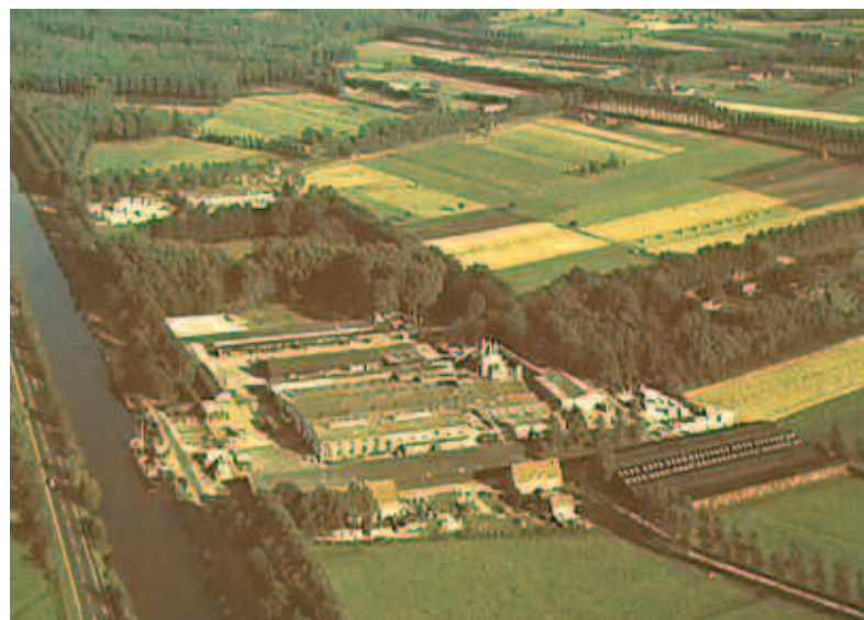
Archieffoto van het complex aan de Molenheide: steenfabriek en timmerwerkplaats.
